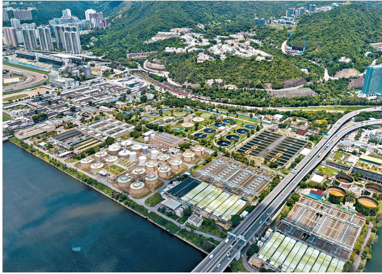
■國家級「裝甲電纜」透過「建築產品認可計劃」(CPAS)在港「落地」，於「搬遷沙田污水處理廠往岩洞」項目中首次應用。
