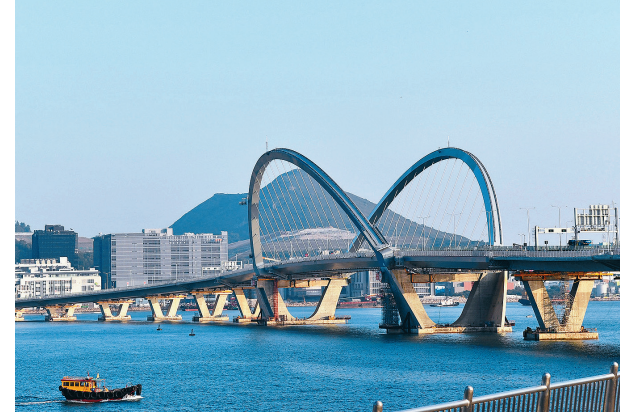
■將軍澳跨灣大橋主跨採用了S690高強鋼。 新華社
